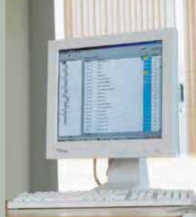
Centrale controle en sturing met ESM - webref. SKX023A3
