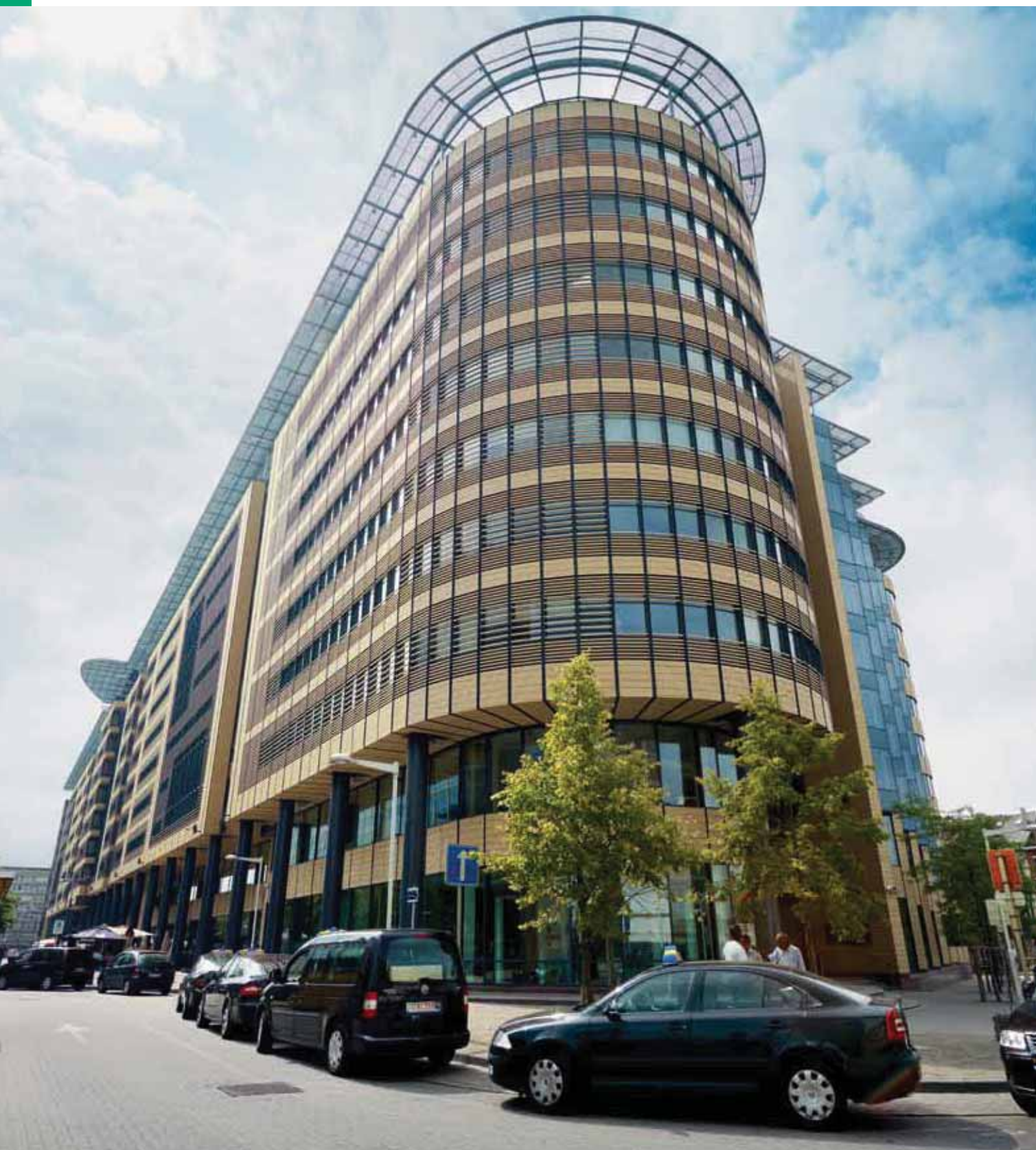
REGIE DES BÂTIMENTS (ÉDIFICE VICTOR HORTA), BRUXELLES – BELGIQUE
