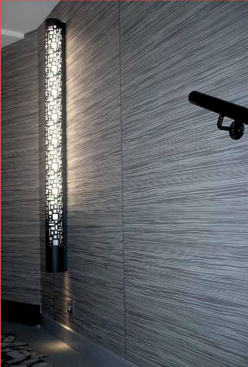
Applique en tôle d'acier et PMMA diffusant pour un tube fluoescnt 54W
