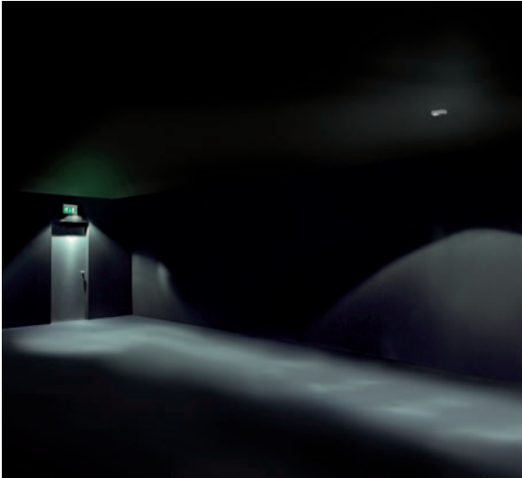
Geavanceerde lichttechniek zorgt ervoor dat u minder armaturen nodig hebt voor de verlichting van de vluchtweg.
