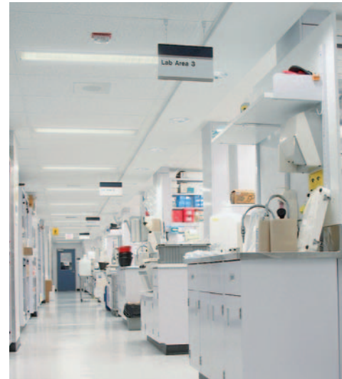
ETAP-reflectoren garanderen door hun lage gemiddelde luminanties een hoog visueel comfort in kantoren en laboratoria.
