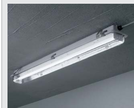
Fig. 38: Terwijl een E12/136HFW (met 1 x 36W fluorescentielamp) een nominale lichtstroom van 3350 lm en een specifieke lichtstroom van 72 lm/W haalt, bereikt hetzelfde toestel met ledtube respectievelijk slechts 1340 lm en 61 lm/W. Ook de lichtverdeling met ledtube (rechts) is anders dan met fluorescentielamp (midden).
