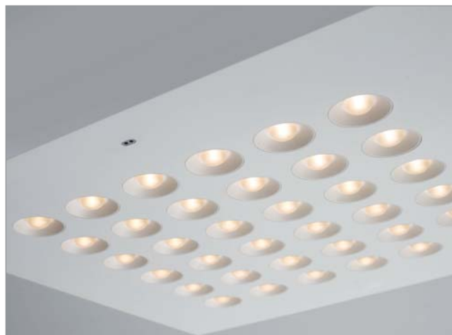
U7 med dagsljusberoende styrsystem för belysning (ELS)
