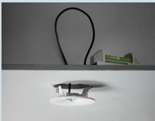
Infälld K1: anslut armaturen genom drivenheten, montera den i taket och klicka fast den.
