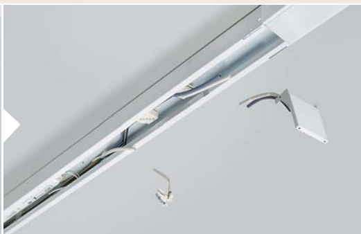
2. kopstukken en aansluiting verwijderen
