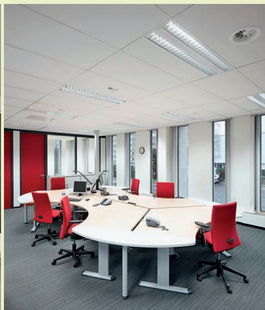
UT1-inbouwarmaturen in de kantoren.
