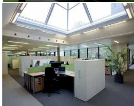
De UT1-hoogrendementarmaturen met diffusoren werden naadloos geïntegreerd in het plafond.
