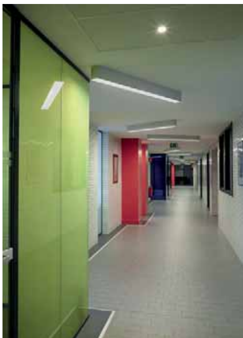
De architect liet de Kardó-armaturen schijnbaar willekeurig tegen het plafond monteren.
