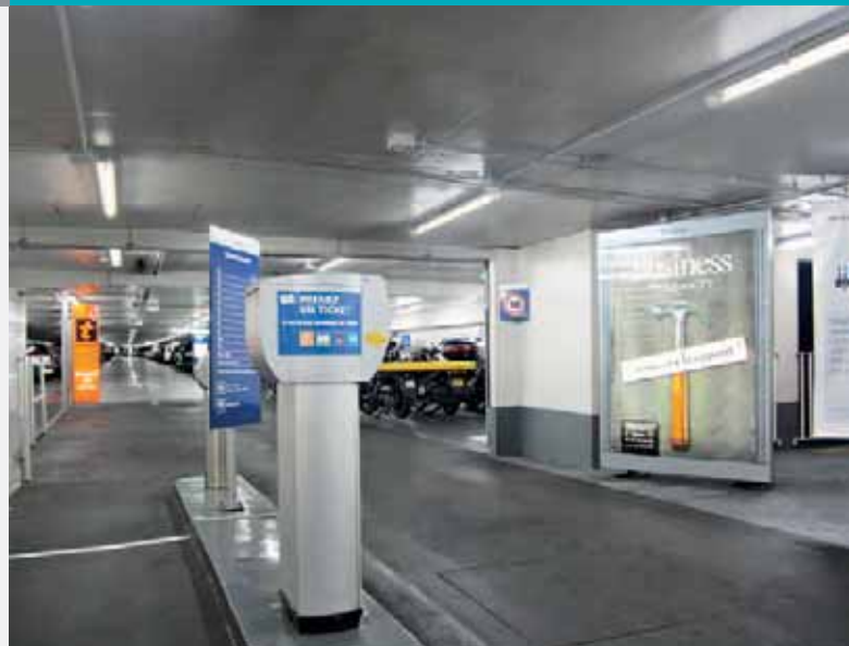
Dankzij de aanwezigheidsdetectoren hoeft de verlichting niet continu te blijven branden.
