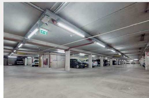
In de parkeergarages zorgt het hoge rendement van de E6-armaturen voor een minimum aantal geïnstalleerde armaturen.
