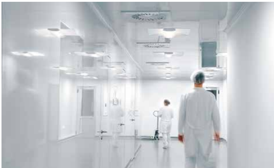
US met led is volledig stof- en vlieg dicht, een voordeel voor omgevingen waarin hygiëne cruciaal is.
