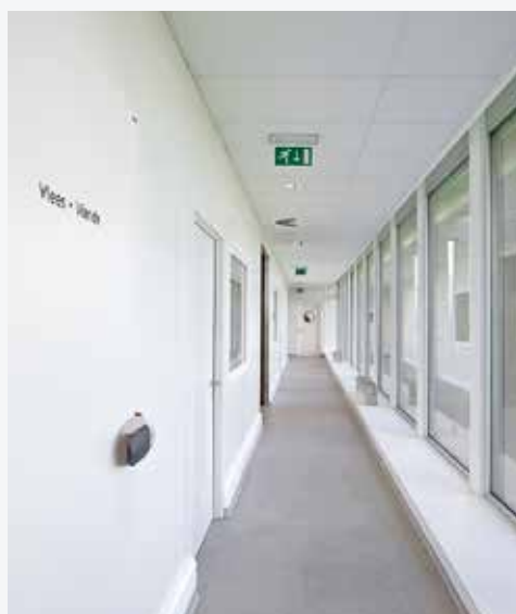
De technische gang is voorzien van K1-signaliseringsarmaturen.
