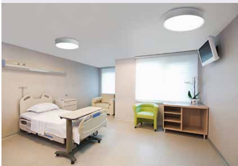
Met twee grote W1-armaturen haalt u in een kamer van 3,5 op 5 meter een verlichtingsniveau van 300 lux.
