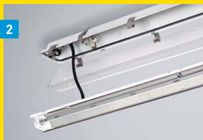
2 Draai de nieuwe beugels vast en sluit de ledmodule (eenvoudig via stekker) aan.
