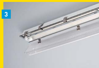
3 Klik de ledmodule vast en sluit de beschermkap.
